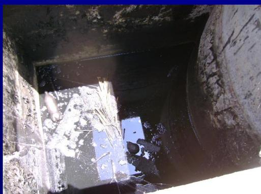
A rede coletora não faz ligação à Estação Elevatória.
