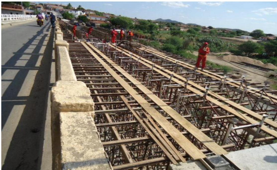
**Foto 10 - Risco de Queda de Material sobre os Operários, Falta de Sinalização e Isolamento**
