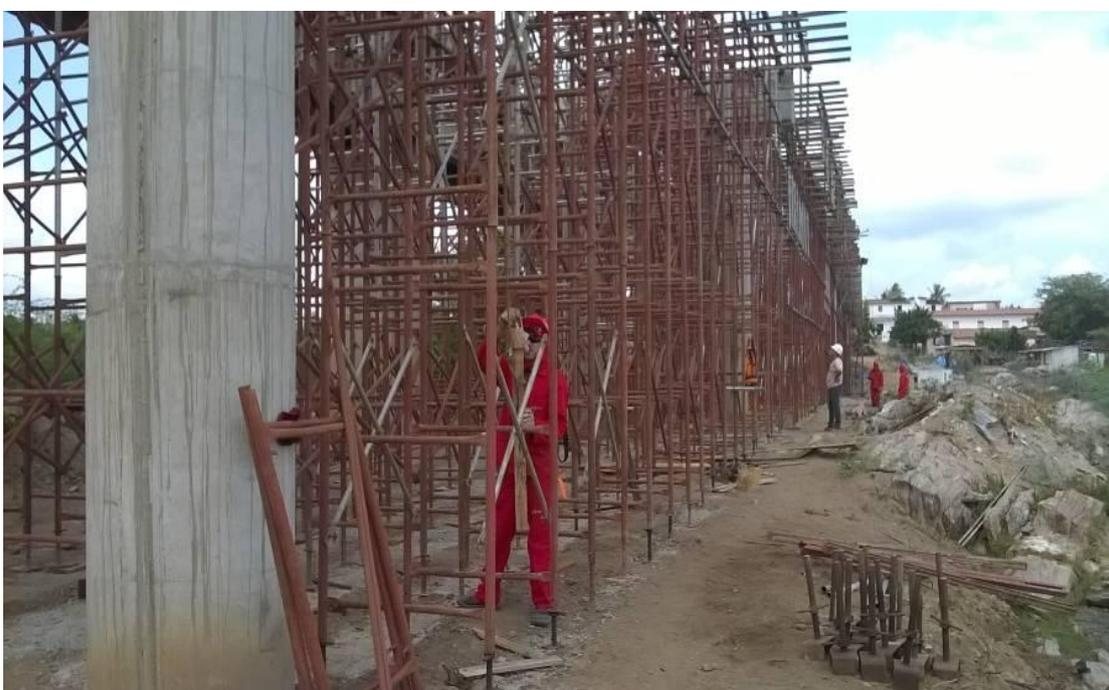
**Foto 11 - Estocagem Inadequada de Material entre Equipamentos e da Movimentação de Operários e Veículos**
