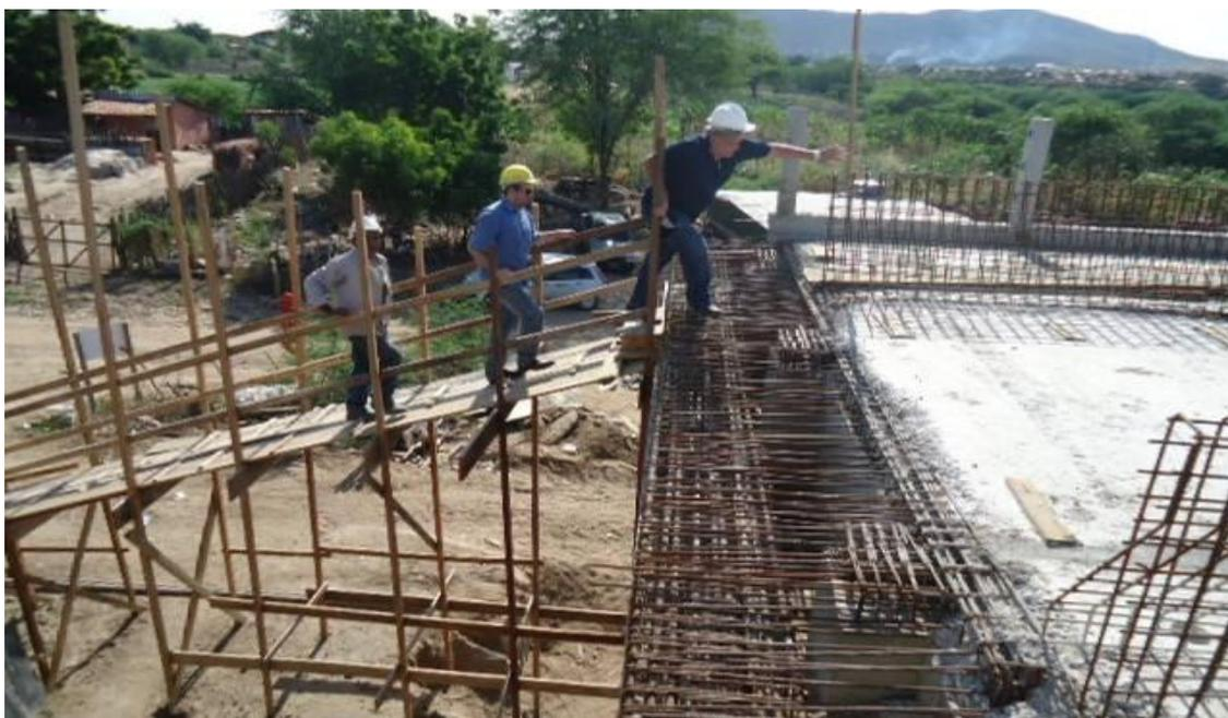
**Foto 9 - Trabalhador Transportando Aço sobre Tábuas sem Cabo-guia de Segurança**
