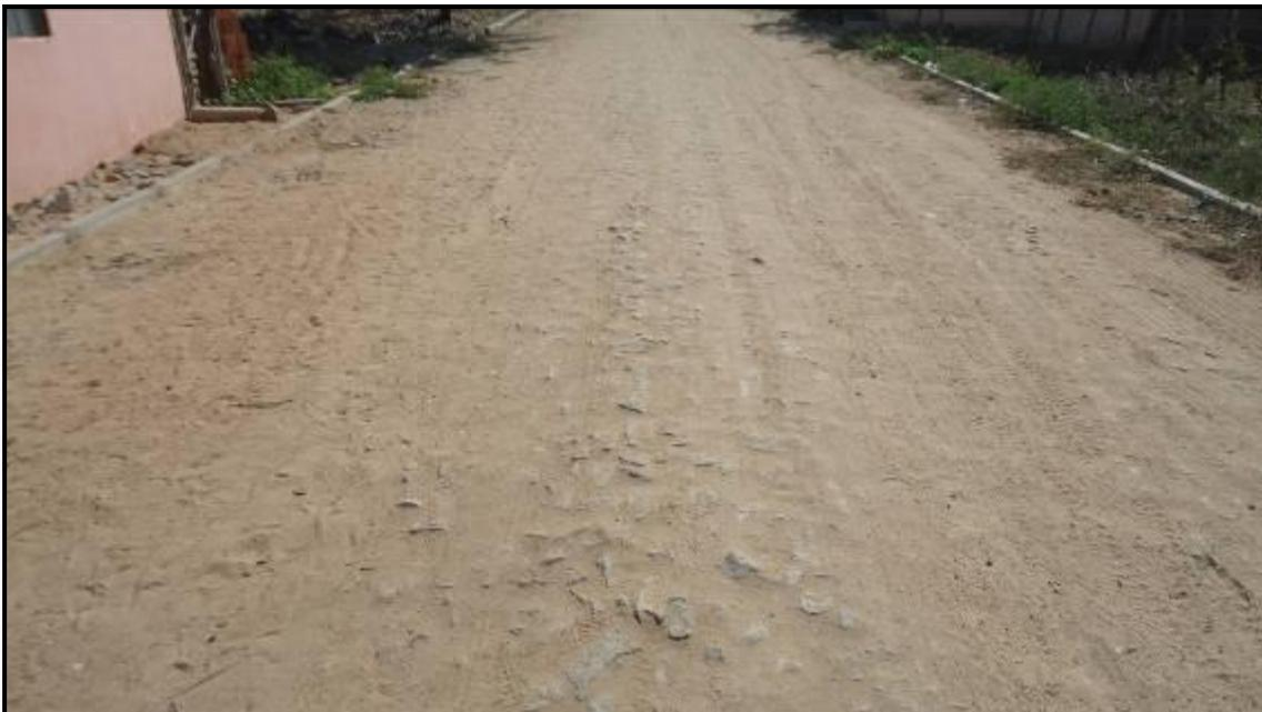
**Figura 21 - Pavimentação da Rua João Oliveira (Trecho 1) executada sem rejuntamento**
