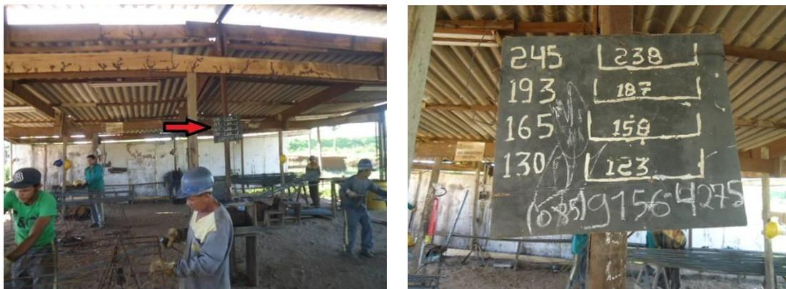
238. A ausência do Projeto Executivo acarreta a falta de elementos necessários à execução da obra em conformidade com o detalhamento previsto pelo calculista, podendo ocasionar problemas de segurança para a estrutura do empreendimento.
