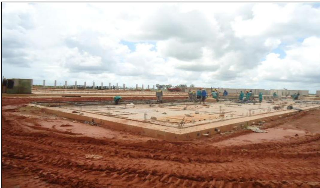
117. São necessários alertas quanto ao isolamento das áreas de transporte e de circulação de materiais por guias, guincho e guindaste (NR 18 - item 18.27.1.a), e identificação de acessos, circulação de veículos e equipamentos na obra (NR 18 - item 18.27.1.h). Constatou-se a falta de sinalização na obra para as vias onde há circulação de veículos e máquinas (figuras 8 e 9).
