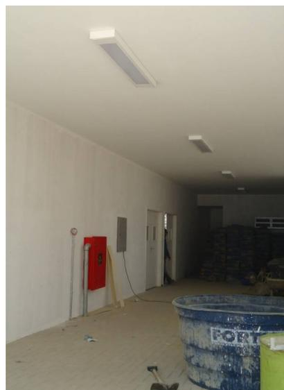
**LUMINÁRIA C (sem difusor):** Luminária de embutir. Iluminação em LED (02 lâmpadas tubulares LED, T5 ou T8, 20W cada ou placas ILED fixadas diretamente ao corpo da luminária). Corpo em chapa de aço tratada e pintada eletrostaticamente na cor branca. Potência máxima do conjunto (tubos ou placas e driver) 44w. Fluxo luminoso mínimo 3200lm. Fator de potência mínimo 0,92, Índice de reprodução de cores maior que 75%.
