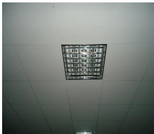
**LUMINÁRIA A (sem aletas):** Luminária de embutir. Iluminação em LED (04 lâmpadas tubulares LED, T5 ou T8, 10w cada ou placas LED fixadas diretamente ao corpo da luminária). Corpo em chapa de aço tratada e pintada eletrostaticamente na cor branca. Potência máxima do conjunto (tubos ou placas e driver) 44w. Fluxo luminoso mínimo 3200lm. Fator de potência mínimo 0,92. Índice de reprodução de cores maior que 75%
