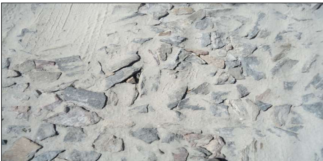
Figura13 – Rejuntamento Superficial do Pavimento
