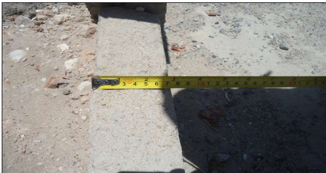
Figura 8 – Detalhe do Meio-fio Executado em Ruas da Localidade de Juritiana
