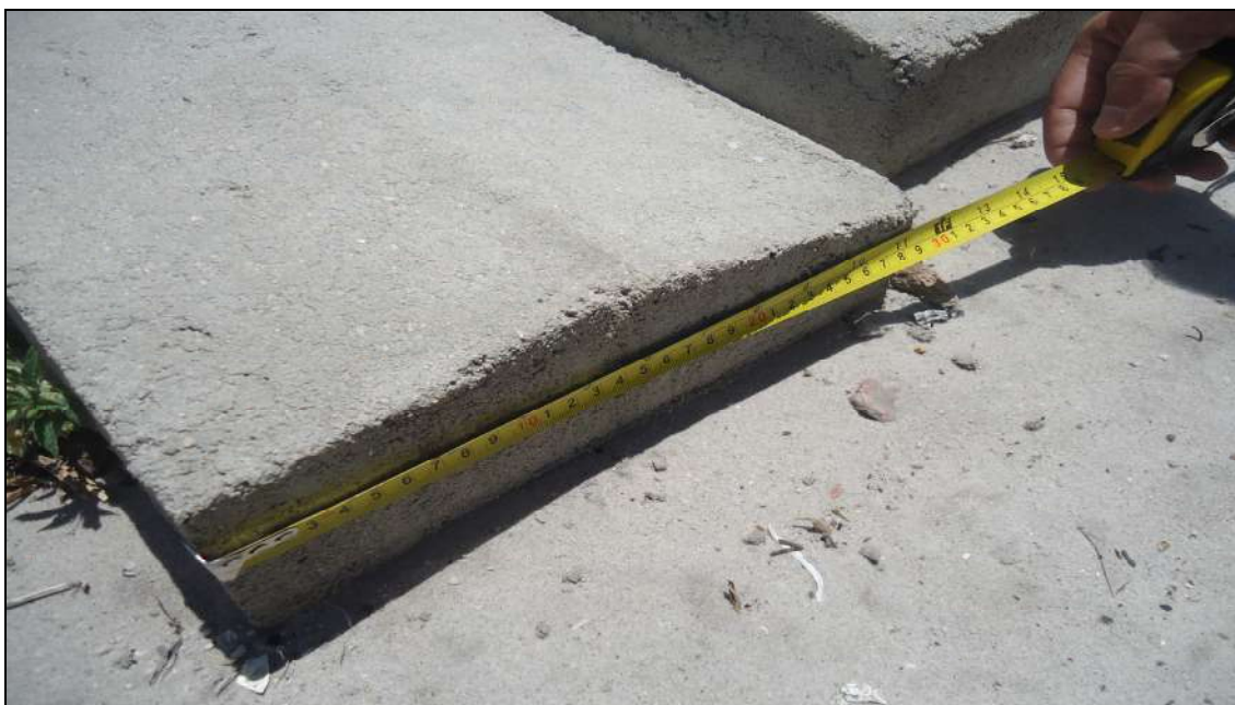
Figura 7 – Detalhe do meio-fio executado em ruas da localidade de Juritianha
