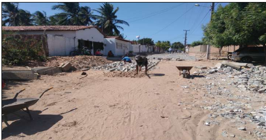
Figura 11 – Assentamento de Pedras Diretamente sobre Terreno, sem Colchão de Areia
