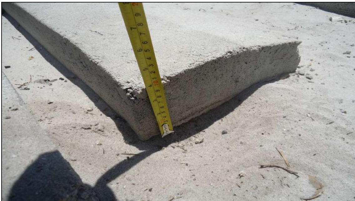
Figura 6 – Detalhe do Meio-fio Executado em Ruas da Localidade de Juritianha
