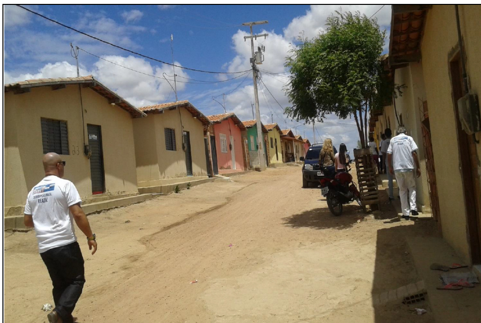
Figura 2 – Casas de um conjunto habitacional
