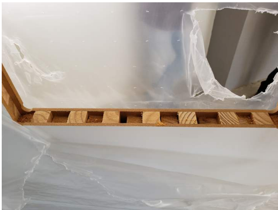
Figura 17 – Detalhe da porta adquirida fora das especificações
