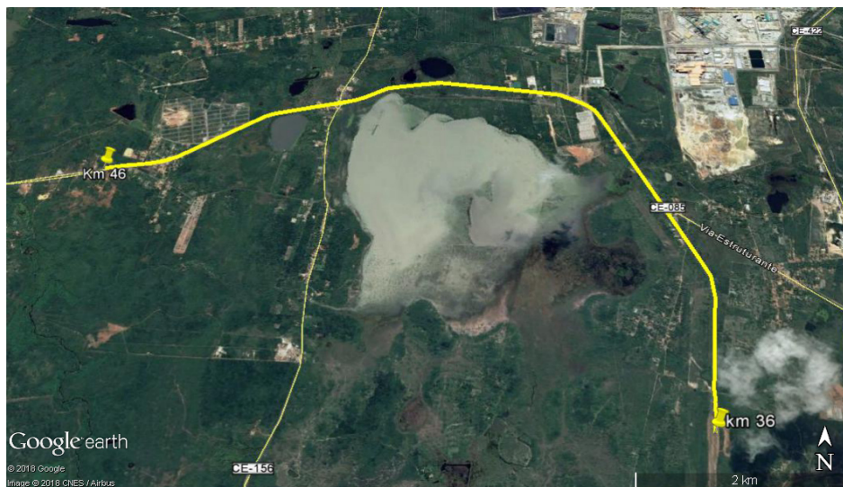
Figura 2 – Primeiro trecho inspecionado
